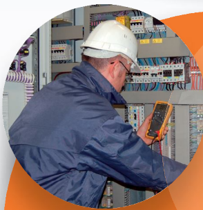
Оборудование, обеспечивающее или улучшающее распределение электроэнергии до точки конечного потребления
